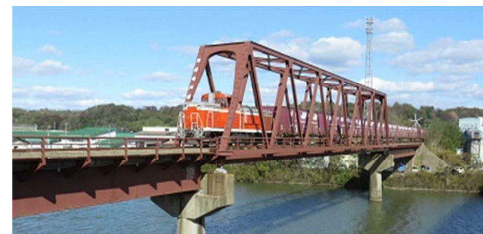
旧雄物川橋梁を通過する車両(令和元年頃)
